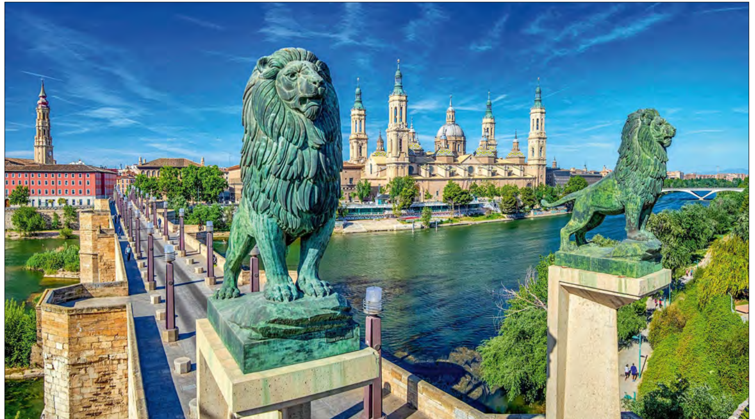
Die steinerne Brücke „Puente de Piedra“, gern auch Löwenbrücke genannt, überspannt den Fluss Ebro in Zaragoza. [Foto Julius]
